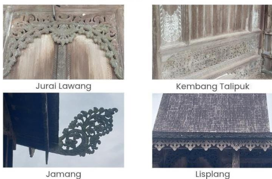
Gambar 4. Ukiran yang ada di Rumah Banjar Bubungan Tinggi di Desa Habirau
