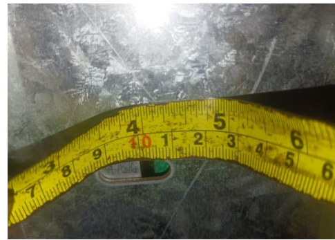
Gambar 13. Pengaturan jarak celah 4mm
