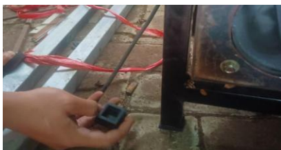
Gambar 25. Pemasangan Karet Peredam
