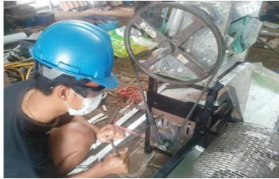
Gambar 24. Pemasangan Motor Dilakukan Pada Dudukan Plat
