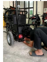
Gambar 11. Pemasangan Komponen Elektrikal Sumber: (Dokumentasi pribadi)
