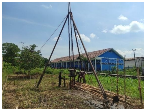
Gambar 5. Pemancangan Tiang Galam Pondasi
