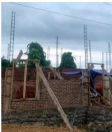
Gambar 3. Pekerjaan Pasangan Dinding Bata Merah Sederhana Pada Lokasi Penelitian Sumber: Hasil dokumentasi peneliti (2026)
