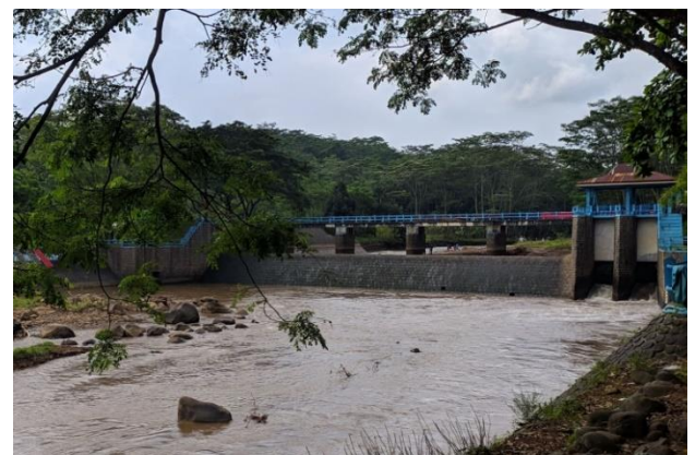
Gambar 1. Bendung Kedungdowo Kramat
