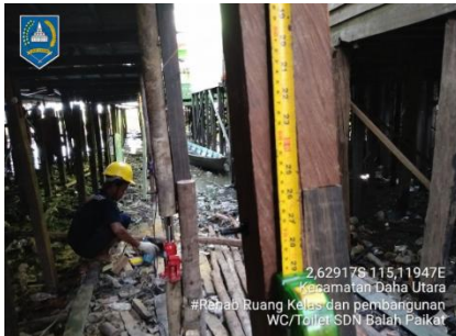
Gambar 3. Pekerja sedang mengangkat tiang pondasi ulin
