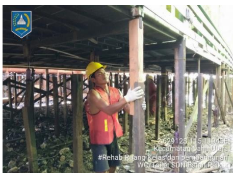
Gambar 4. Pekerja sedang posisi tiang pondasi ulin
