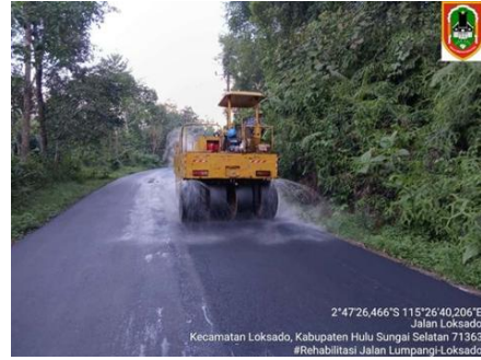
Gambar 7. Pemadatan antara (intermediate rolling) agar pori-pori tertutup rapat
