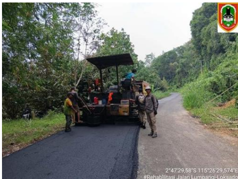
Gambar 5. Proses asphalt finisher menghamparkan aspal panas di atas permukaan jalan
