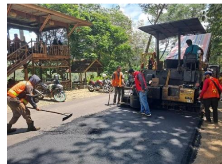
Gambar 9. Perbaikan lokal
