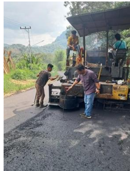
Gambar 8. Pengecekan kerataan, ketebalan dan kepadatan
