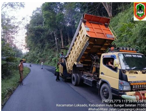
Gambar 4. AMP diangkut menggunakan dump truck
