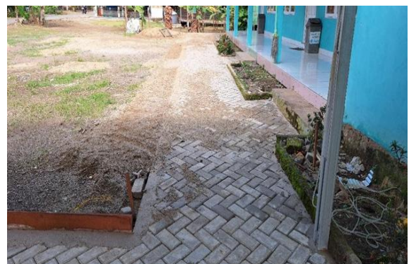
Gambar 2. Proses Pemasangan Paving 100%
